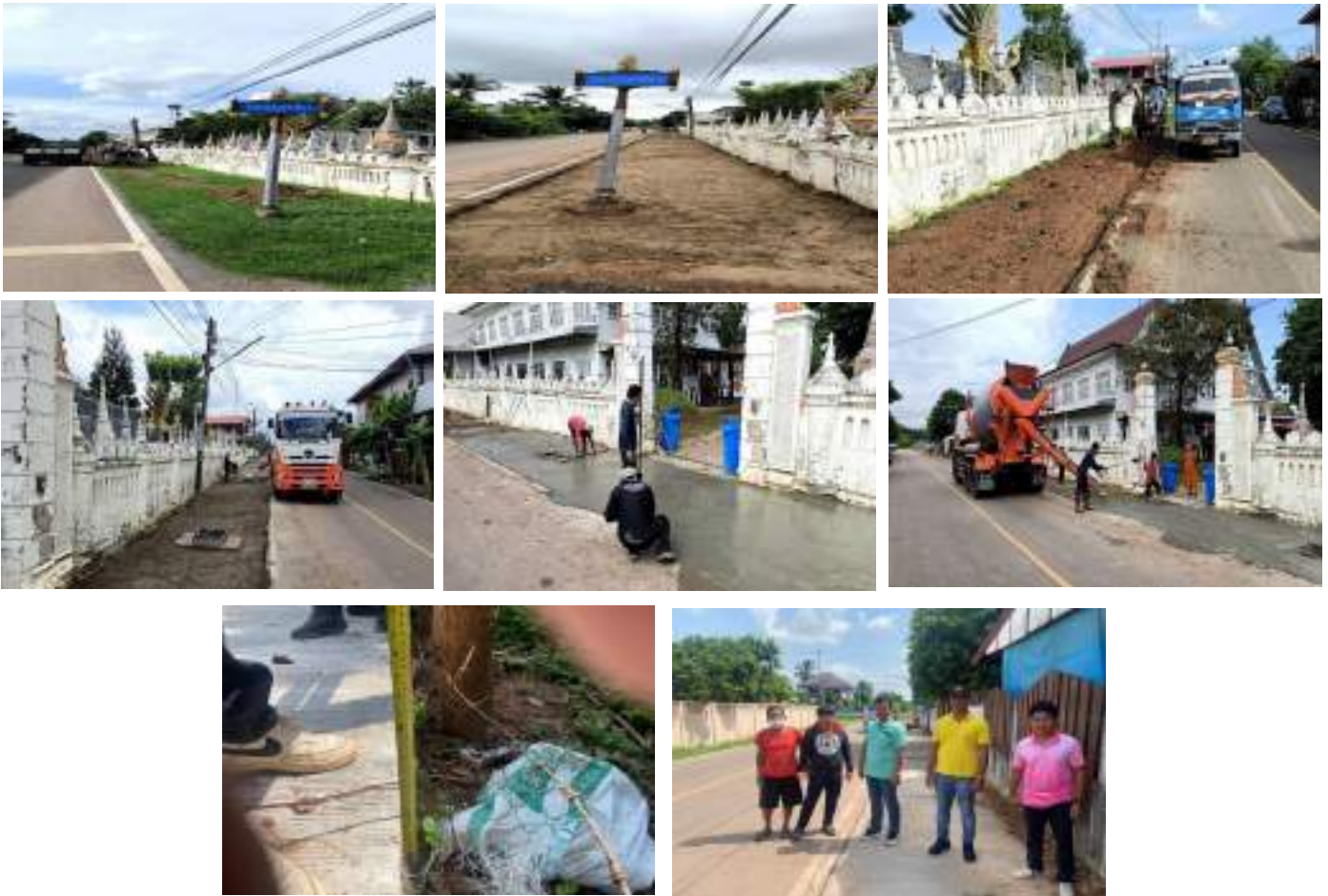
โครงการก่อสร้างขยายถนนคอนกรีตเสริมเหล็ก ถนนนิราศทุกซ์ ด้านทิศตะวันออก จากแยกถนนราชกิจรังสรรค์
